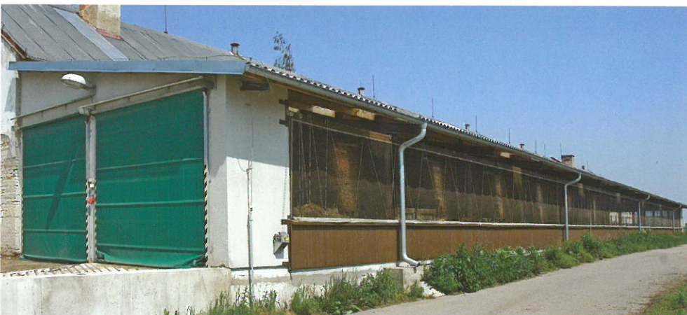
Lochenice – přístavba krmiště, investor p. Václav Bouček
