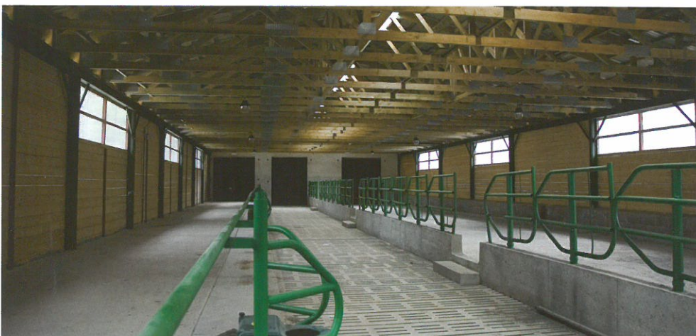
Uhřínov pod Deštnou – novostavba stáje pro dojnice
